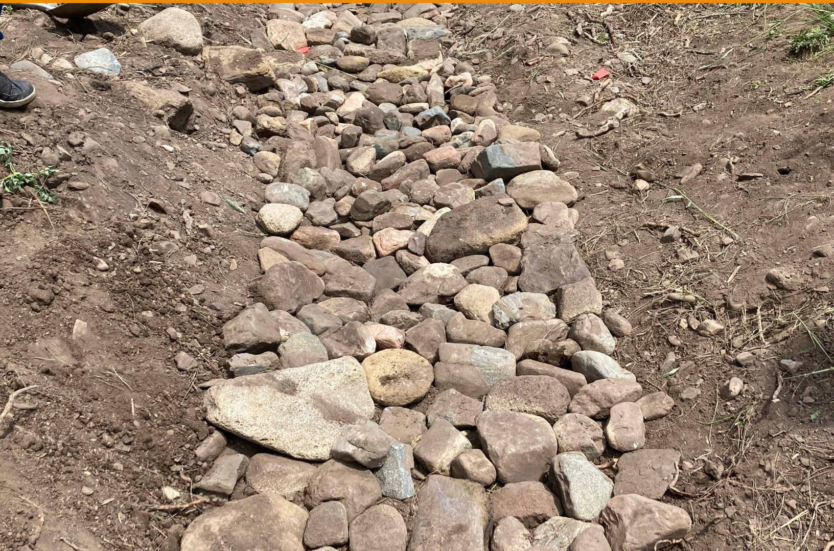
Rampa de Roca construida por cuadrillas estacionales de HPWA en Sapello, Nuevo México (verano del 2023)
