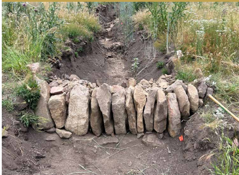
Dique de una Piedra (ORD) construido por cuadrillas estacionales en Sapello, Nuevo México, antes, y después llenándose de sedimentos (verano del 2023).
