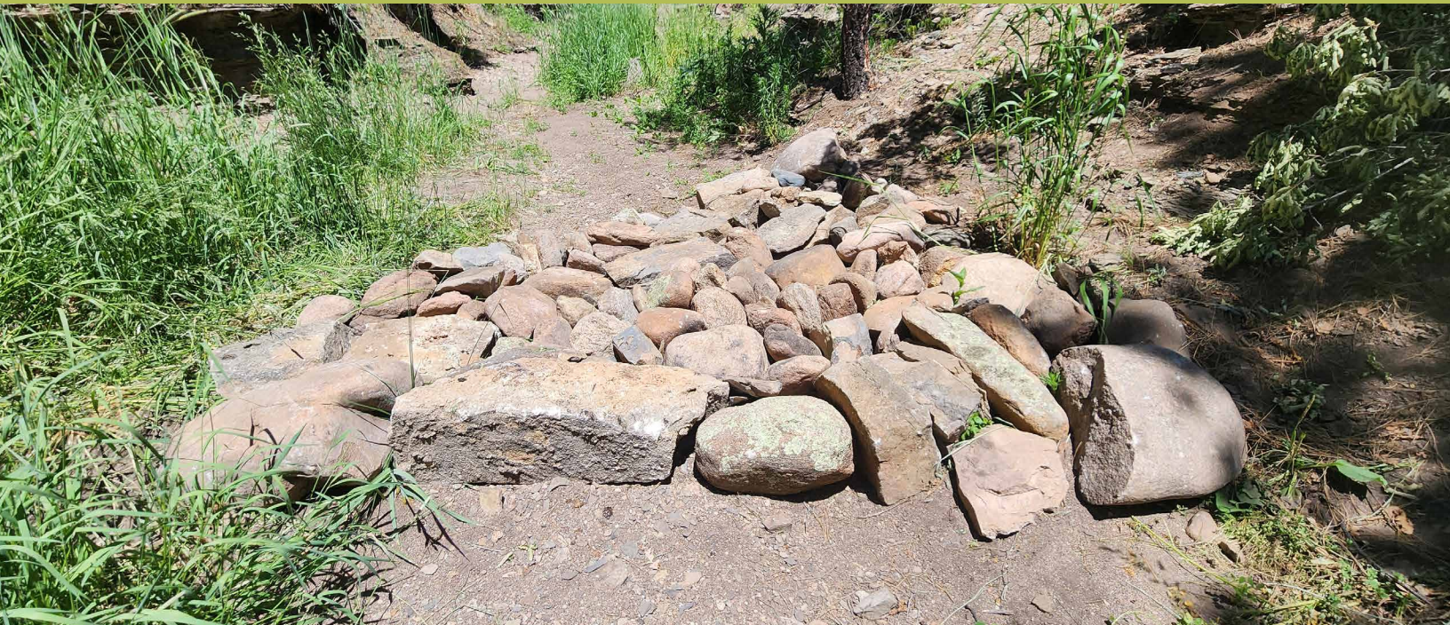
Deflector construido por cuadrillas estacionales de HPWA en Gallinas (verano de 2023).
