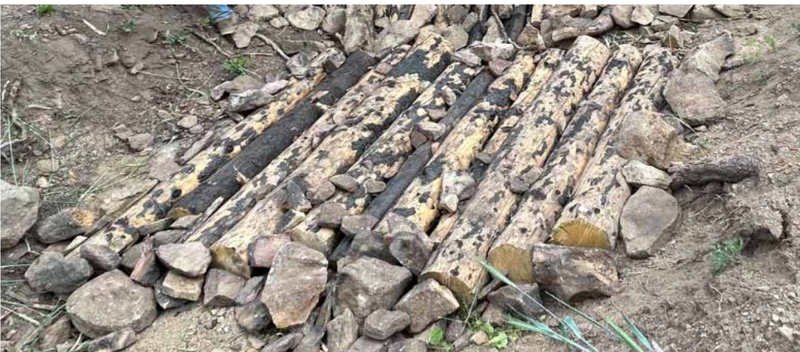
Alfombra de Troncos construida por cuadrillas estacionales de HPWA y FSG en Sapello (verano de 2023).
